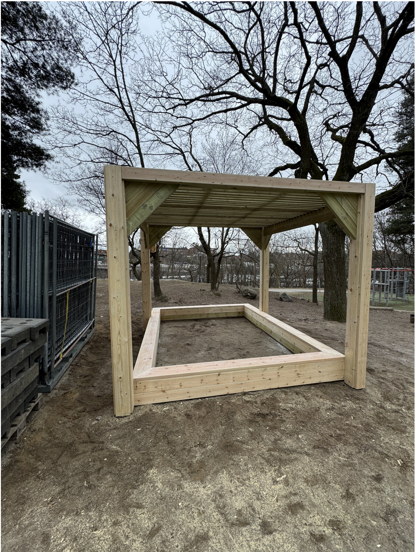
Bild 1: Hela konstruktionens stomme, stolpar samt tak är byggt i tryckimpregnerat trä. Därefter har sittytter samt stolpar klänts med annat virke.
