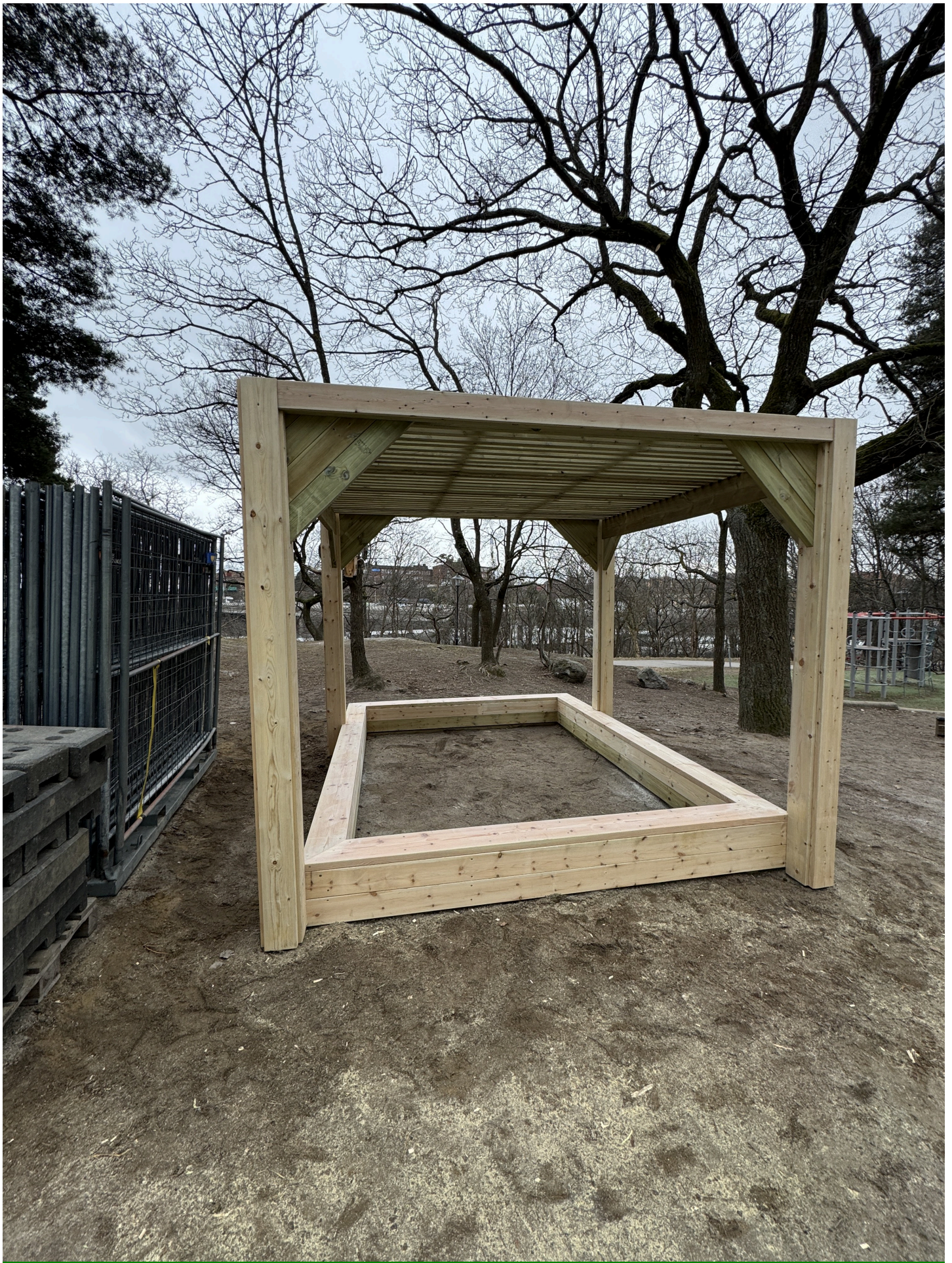
Bild 1: Hela konstruktionens stomme, stolpar samt tak är byggt i tryckimpregnerat trä. Därefter har sittytter samt stolpar klätts med annat virke.
